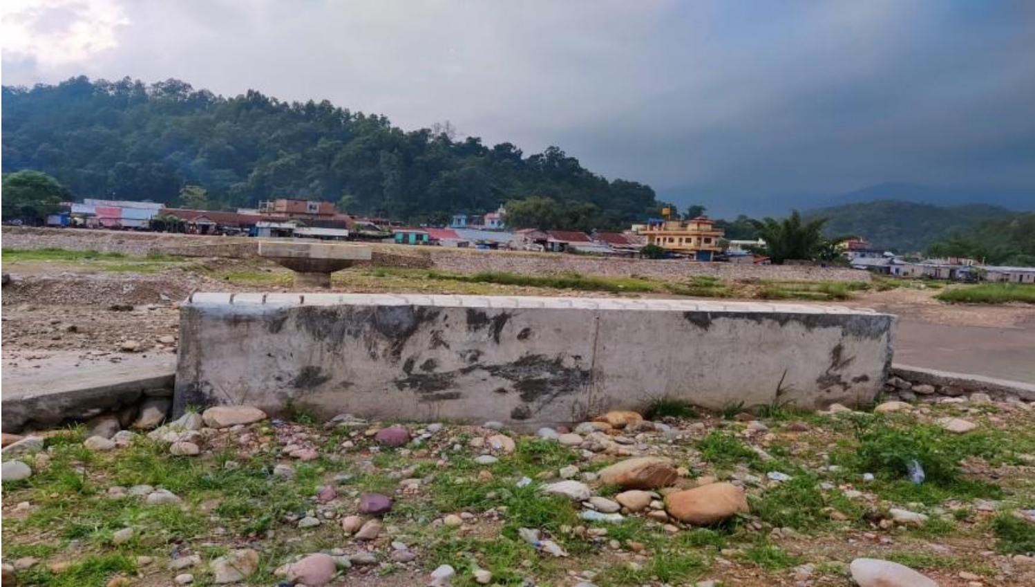
निर्माणाधिन चौराहा खोला बेलिब्रिज
