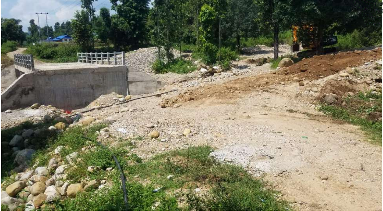
लम्काना साततले बक्स कल्भर्ट Gap Filling, बागमती-०४
