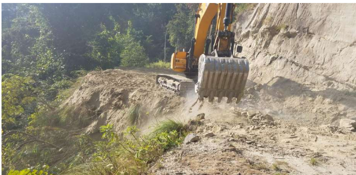
सडक सरसफाई/भिर काटेको, कुटीभकारी देखि देउजर जाने बाटो, बागमती-०३
